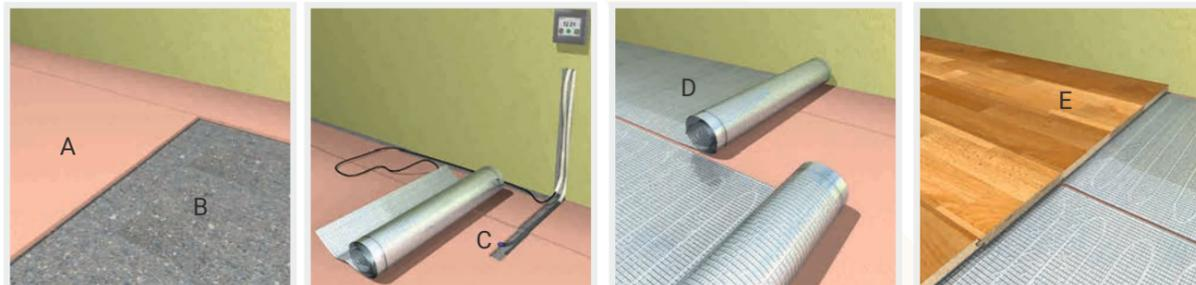
A: Trittschallisolierung / B: Estrich / C: Installationsrohr für Fußbodenfühler / D: Alu-Heizmatte / E: Schwimmend verlegter Laminatboden
